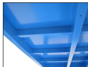
Particolare dei tubolari di rinforzo del piano superiore
